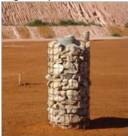
Figura 8: Exemplo de dreno de gases implantado.
